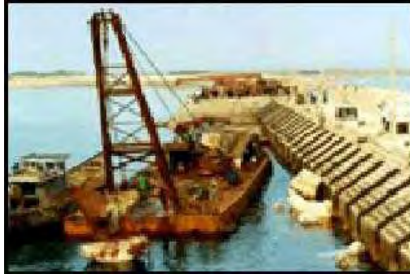
Hình 29. Bến cảng cá và Cầu tàu Bạch-Long-Vĩ được xây cất.
